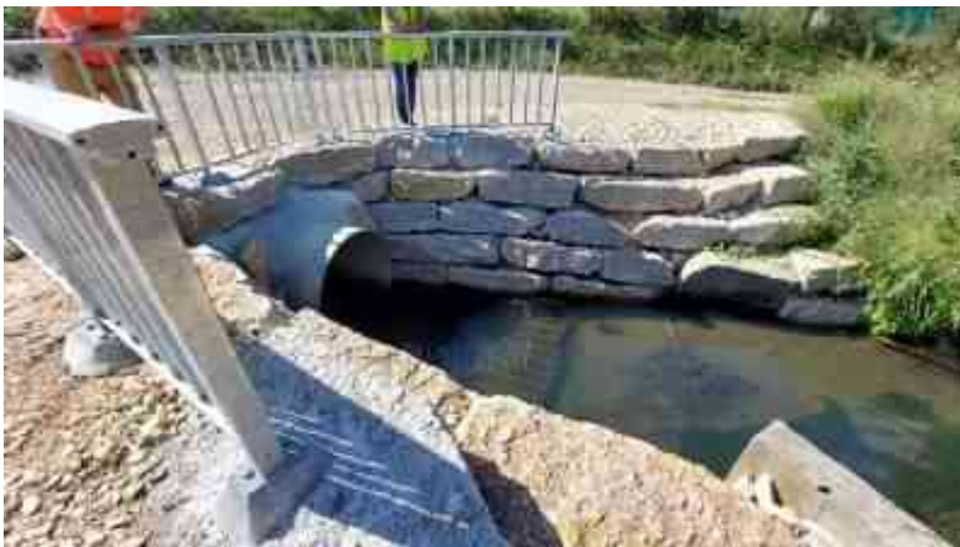
Figure 8 : Buse avec tube PRV
