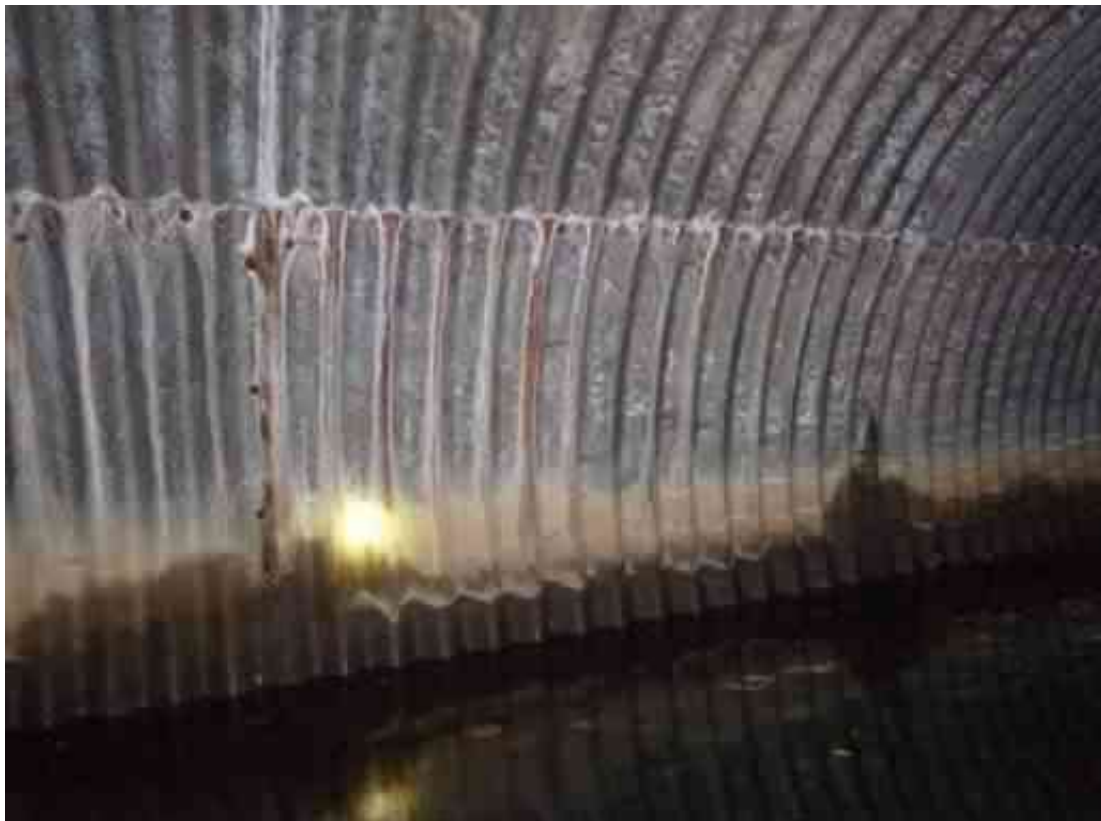
Figure 5 : Couleurs d'oxydation
