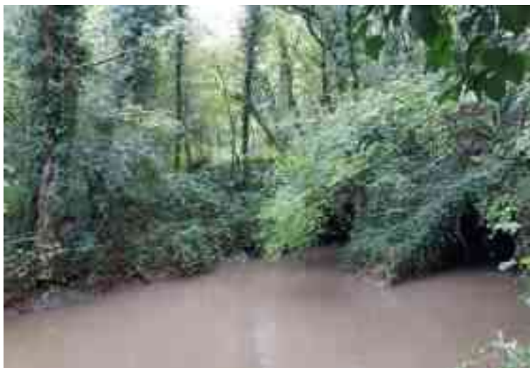
Figure 11 : Vue sur tête de buse Aval
