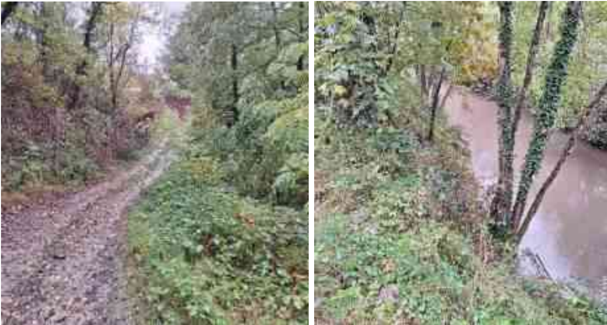
Figure 10 : Photo 04. Piste d'accès tête amont & Talus tête amont
