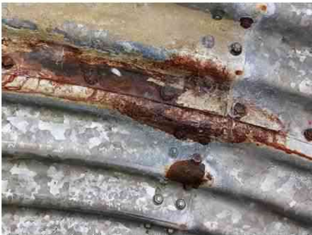
Figure 6 : Buse côté Genève – Boulons oxydés et foisonnés
